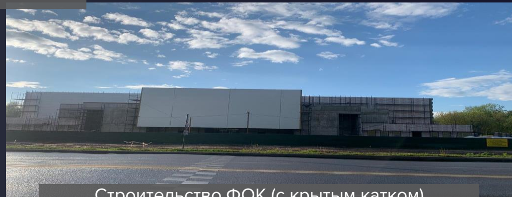
Строительство ФОК (с крытым катком) г.Орехово-Зуево, ул.Гагарина
