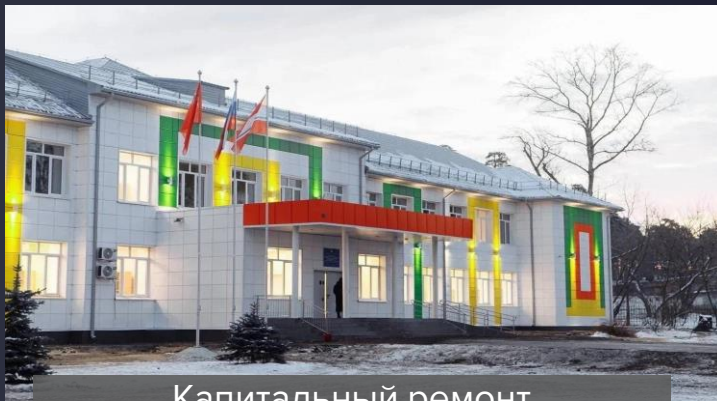
Капитальный ремонт МОУ Ликино-Дулёвская ООШ №4
